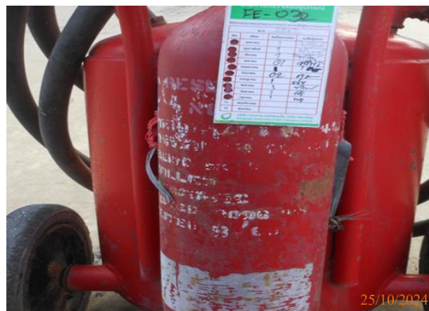
รูปที่ 3-10 การตรวจเช็คอุปกรณ์ดับเพลิงแบบติดล้อ บริเวณหน้าท่าเทียบเรือ
