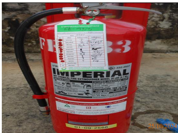
รูปที่ 3-9 การตรวจเช็คอุปกรณ์ดับเพลิงแบบมือถือ บริเวณหน้าท่าเทียบเรือ
